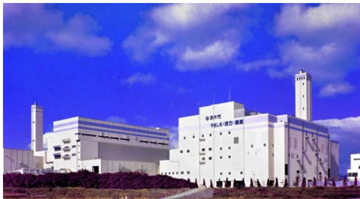
茨木市環境衛生センター
