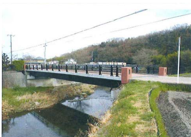
改修後の橋梁（山下橋）
