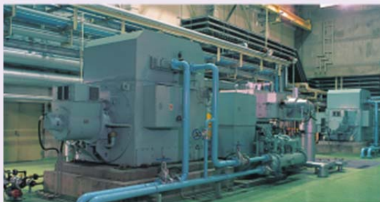
蒸気タービン発電機（環境衛生センター内）
